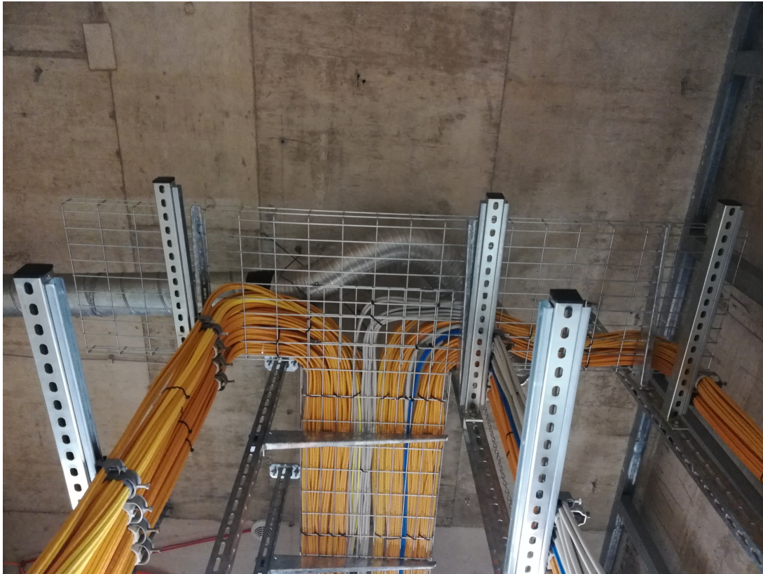
Abbildung 9: Verlegung in Gitterwannen
