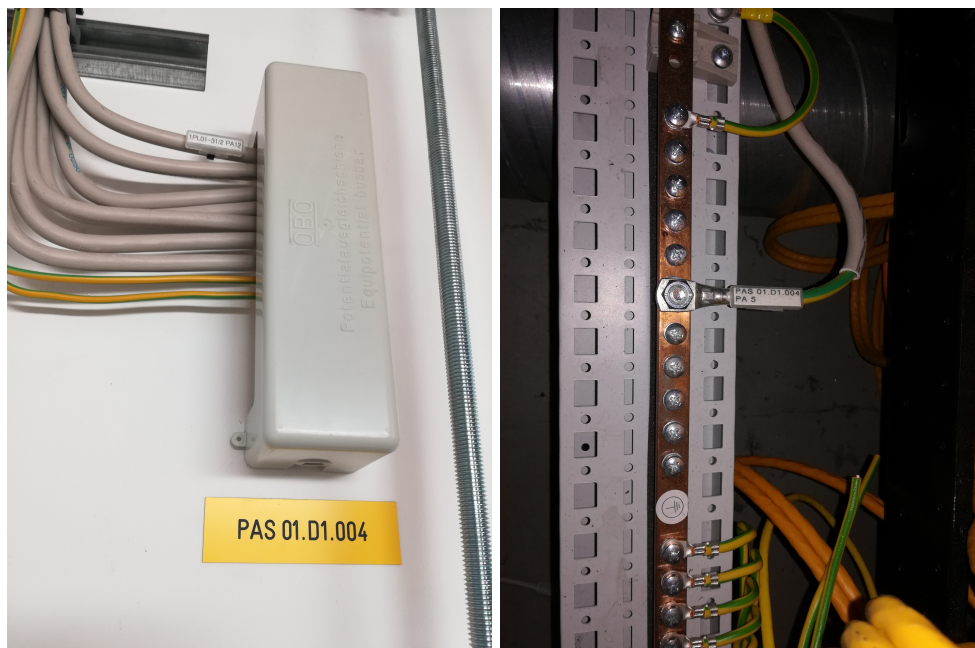
Abbildung 15: Potentialausgleichsschienen
