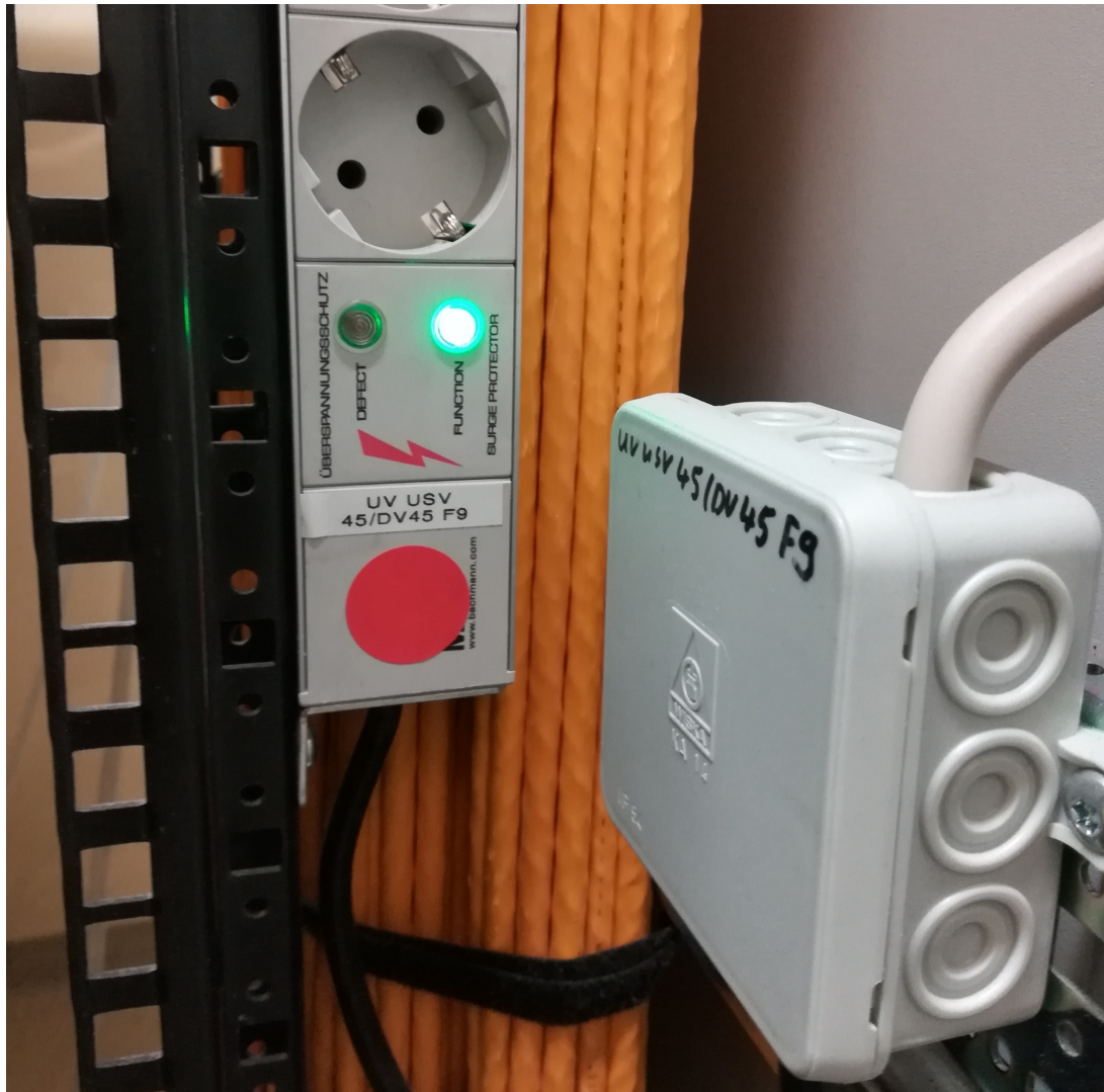
Abbildung 19: Beschriftung von Stromleisten
