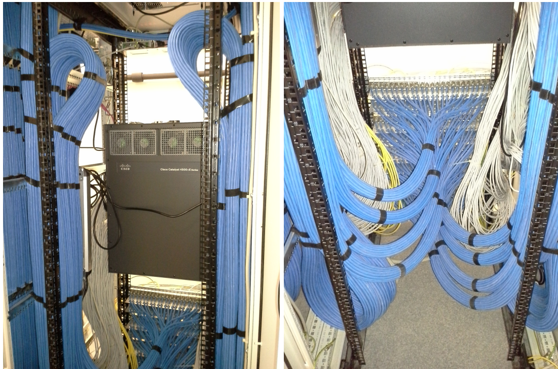
Abbildung 12: Installation von TP-Leitungen
